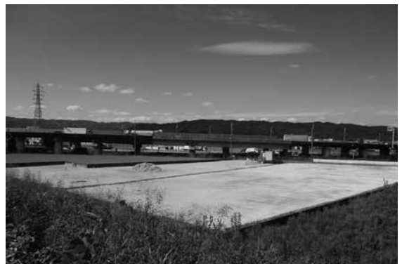
解体後の美化センター跡地
