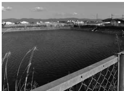
治水対策を実施しているため池（藤池）
