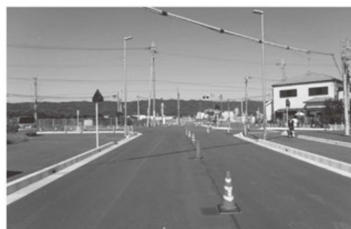
完成間近の県道大和郡山・広陵線 JR踏切付近
