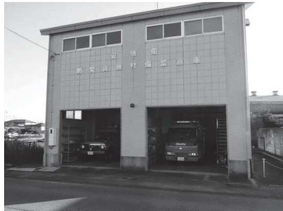
防災資機材備蓄倉庫
