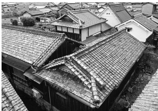
荘司家住宅 全景(北東側より撮影)
