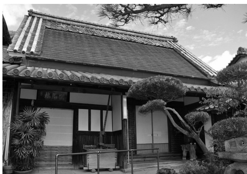
荘司家住宅 主屋玄関付近
