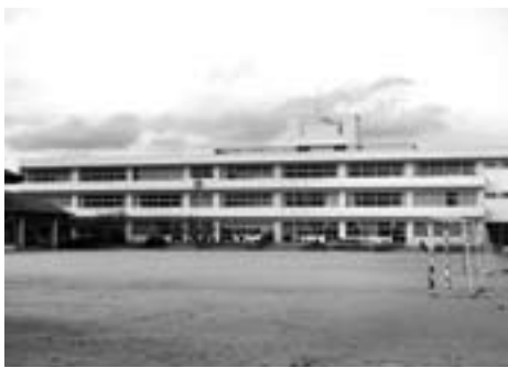
安堵小学校 校舎南面
