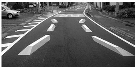
実際の段差をつけず、舗装面に 図柄を描いたイメージハンプリ
