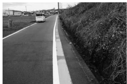
笠目地区の危険箇所 (佃池南側道路)
