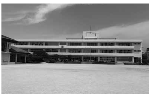
安堵小学校校舎南面
