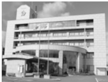
安堵庁舎4階・議会棟
