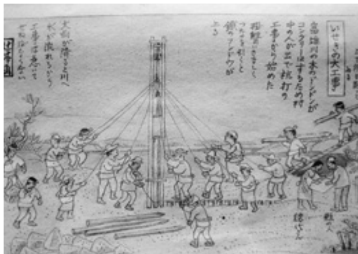
富雄川いせきの大工事 (杭打ち)
